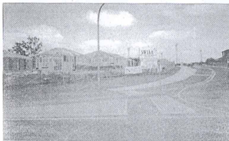
Le villette in corso di realizzazione al Villaggio della S.W.I.A.A.
